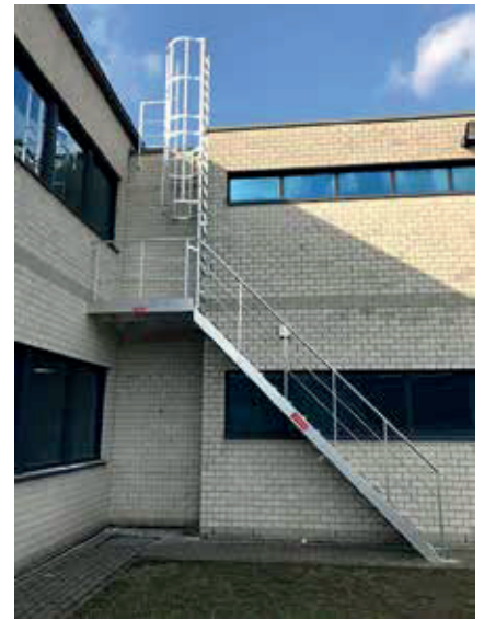
• Escalier + échelle à crinoline
