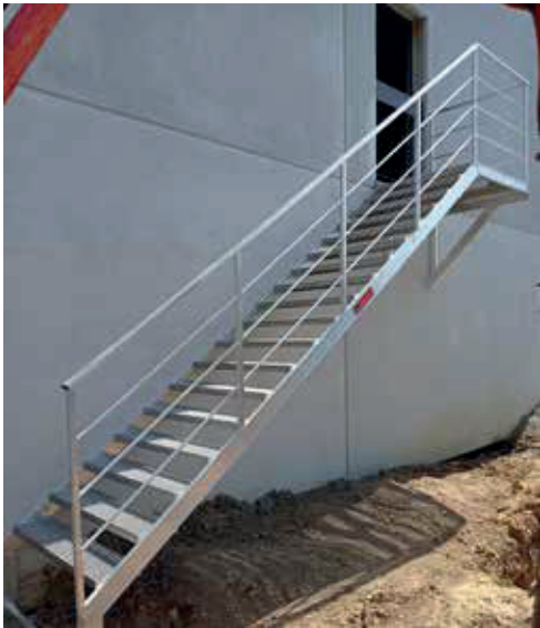
• Escalier d'accès extérieur
